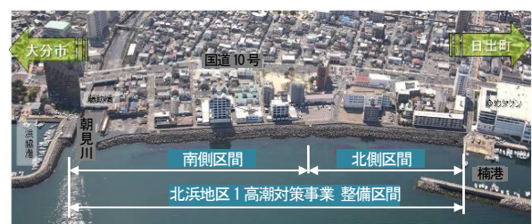
写真-3 北浜地区1護岸の全景（着工前）
