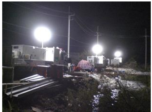
写真6 夜間作業の状況
