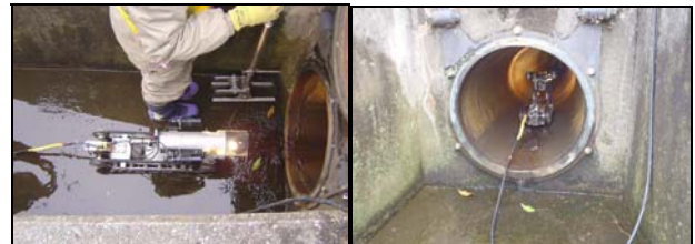
写真-1 (左右) 自走式カメラによる函内観察 [坂川：大金平第三樋管]
