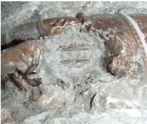
写真-3 はつり調査(P7-A2 G4桁 PC鋼材状況)
