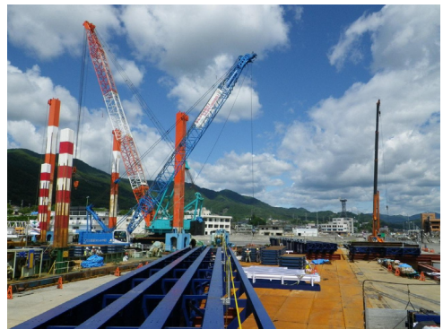
写真-5 桁材地組状況（茶屋前ヤード）
