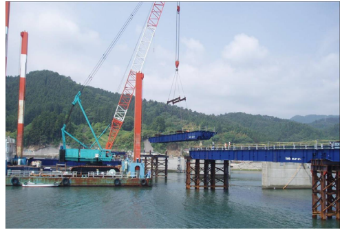
写真-4 上部工桁架設状況
