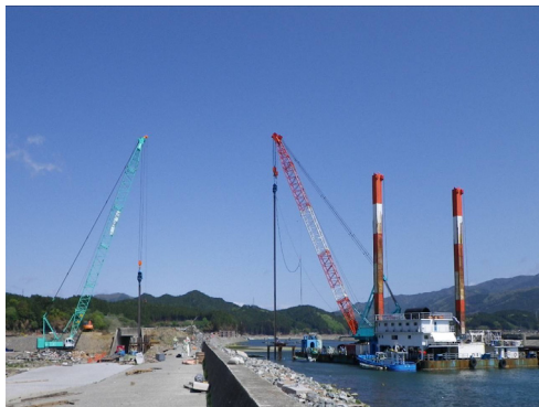
写真-2 水上・陸上同時施工状況
