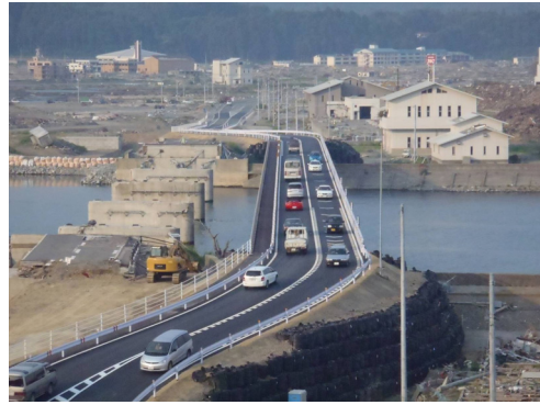
写真-9 仮橋供用開始当日の交通状況
