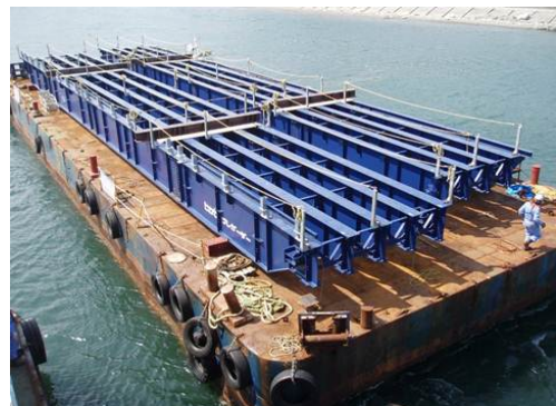
写真-6 桁材海上運搬状況
