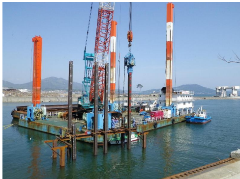
写真-3 水上杭打設状況
