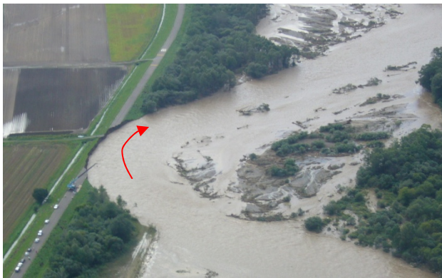
写真-4-3 堤防一部流出箇所付近
