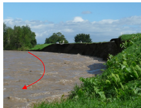
写真-4-2 KP18.2 堤防一部流出箇所
