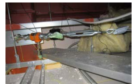
図-22 ロードセル設置
