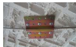
図-20 ケーブル、金具設置
