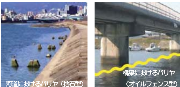
写真-2 物理的な再係留防止策
