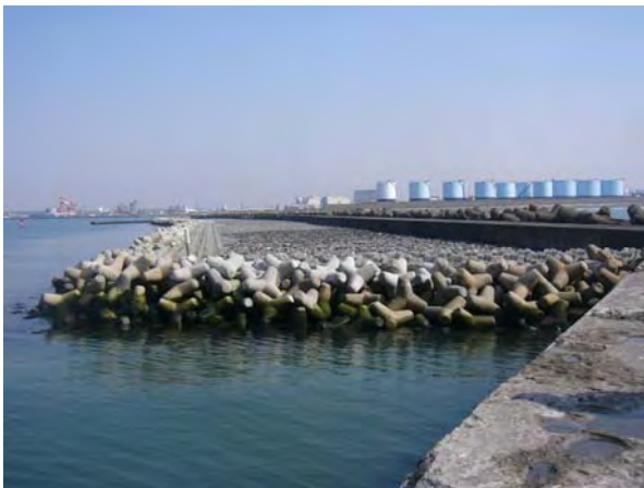
写真-3 長周期波対策工沖側端部 (2012年4月撮影)
