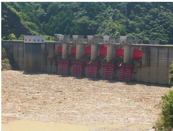
写真-1 海岸・河川・ダムに堆積した流木
