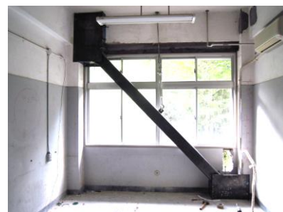
写真-8 完成写真
