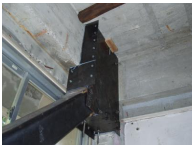
写真-6 上側接合部
