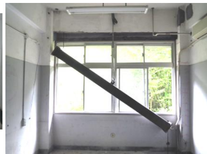
写真-5 鋼管吊上げ
