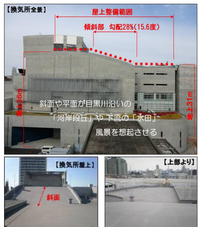
写真-2 換気所屋上概要
