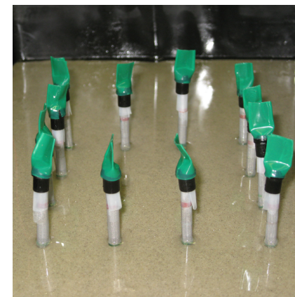
ドレーン設置
