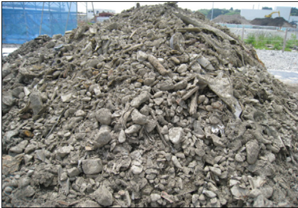
一次処理後のがれき・ごみ・礫 (スケルトンBH処理: 100mm以上)
