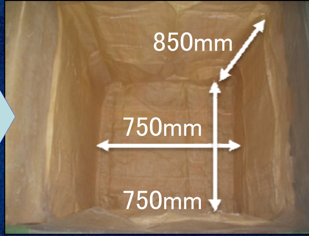
②大型土のう袋の設置
