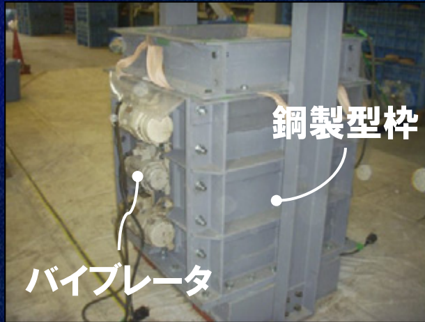
①型枠組立
