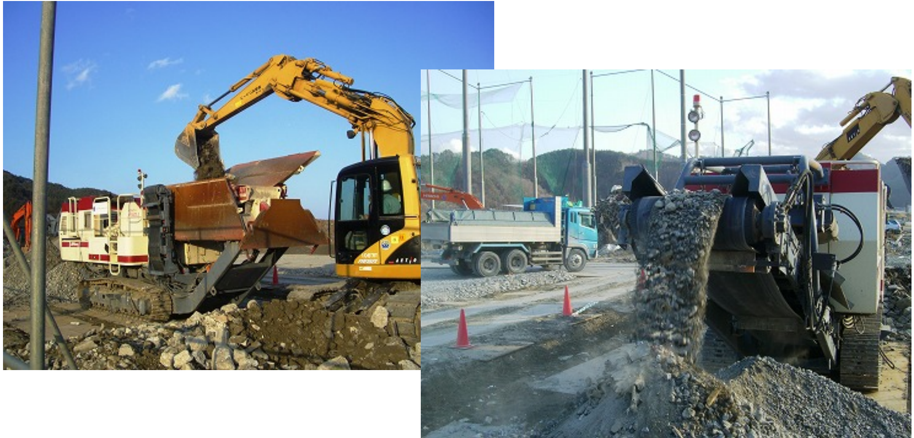
移動式破碎装置 (ガラパゴス) による破碎状況
