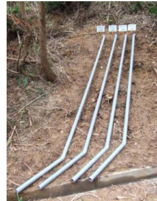
排水ボーリングの設置
