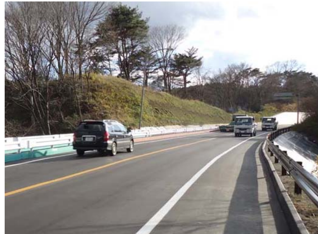
H23年12月26日 本復旧完了
