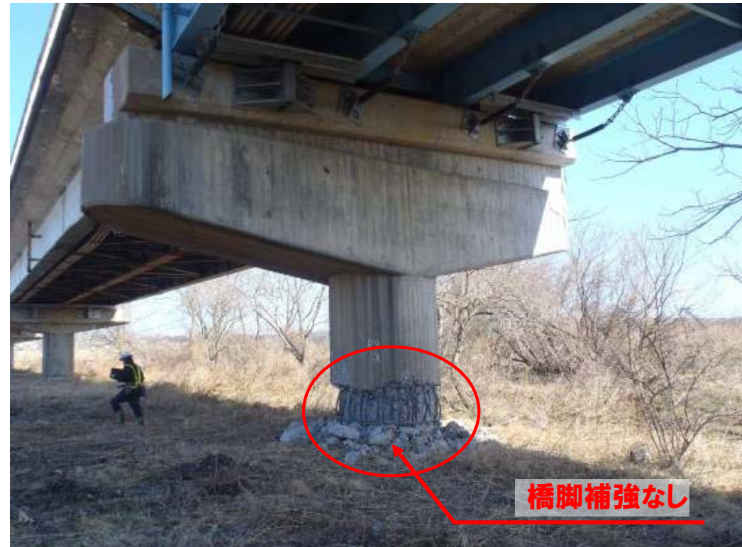
県道 (観測震度: 震度5弱 )
