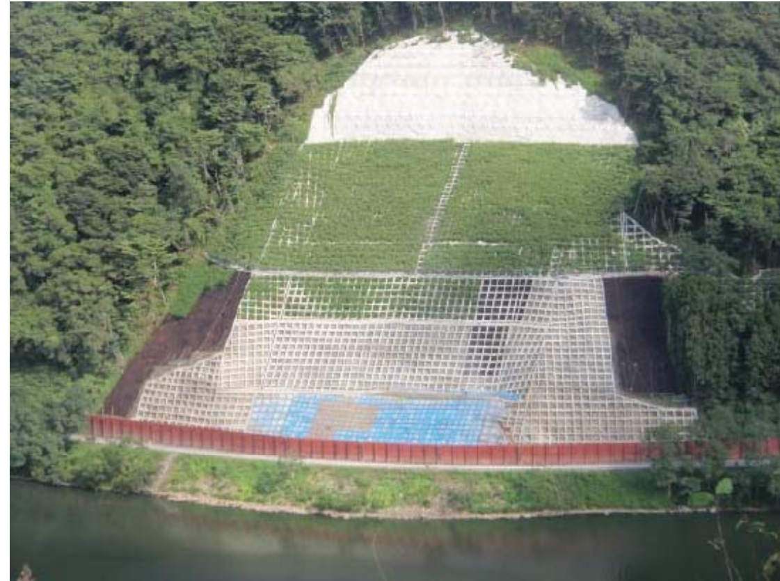
H24年9月28日 本復旧完了
