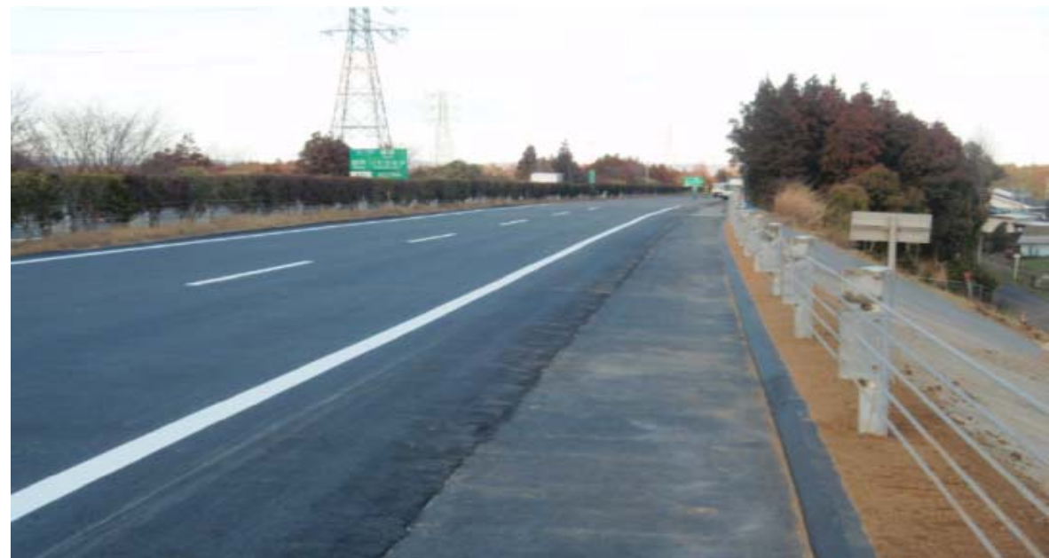
H23年3月17日 本復旧完了
