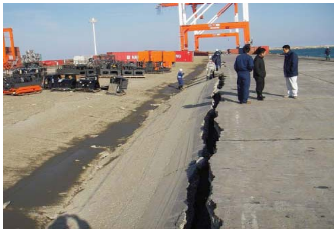
茨城港常陸那珂港区 北埠頭地区 岸壁(-12m)
