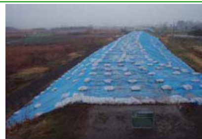
ブルーシート 堤防浸水防止
