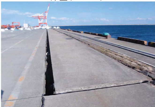
茨城港常陸那珂港区 北埠頭地区 岸壁(-10m)
