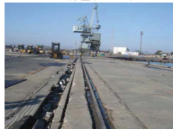
鹿島港 南公共地区 G岸壁(-10m)
