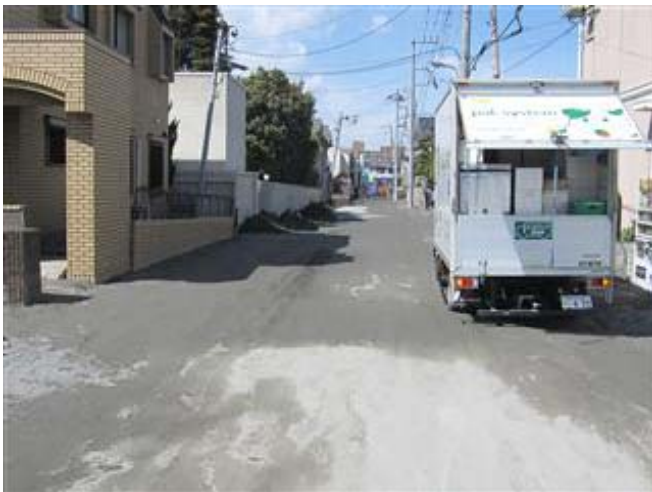
液状化被害(道路)
