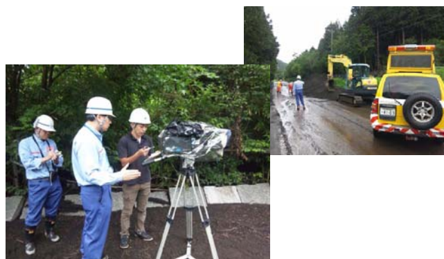
写真-4 災害現場で復旧作業を報道機関に積極公開
