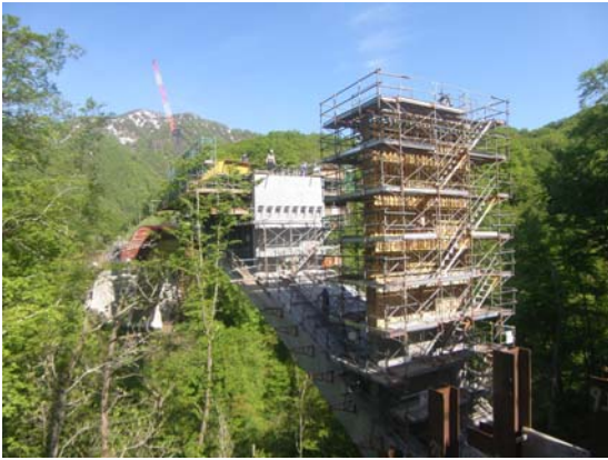
写真－11 鉛直材施工状況
