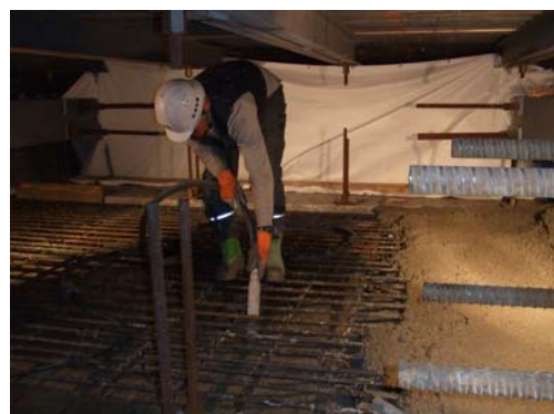
写真-10 閉合部コンクリート打設状況
