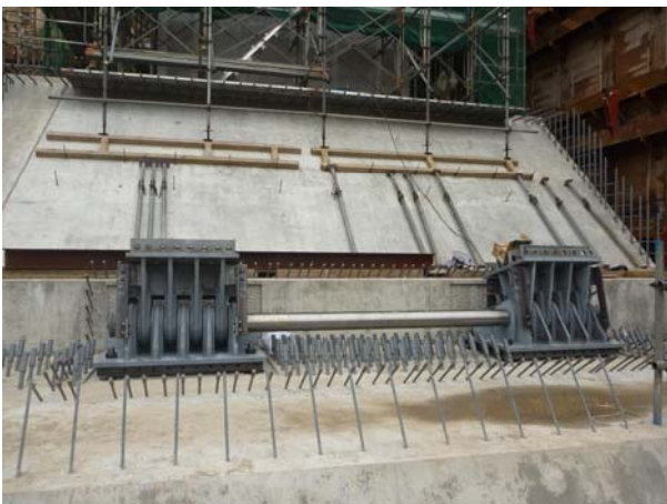
写真-8 連結ピン設置状況
