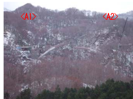
写真-5 A1側4次ロアリング状況
