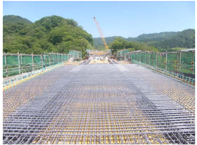
写真－12 補剛桁施工状況
