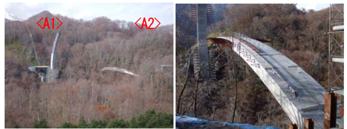
写真-6 A2側4次ロアリング完了時状況
