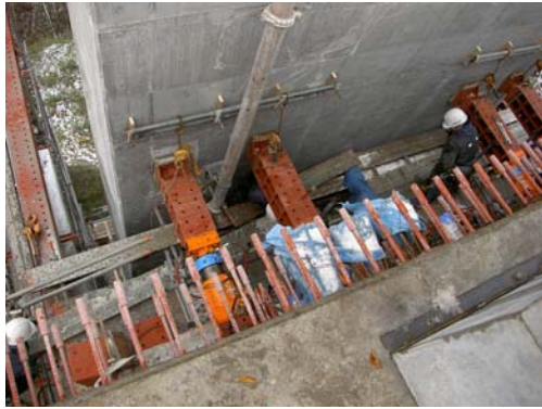
写真-1 押しジャッキ設置状況
