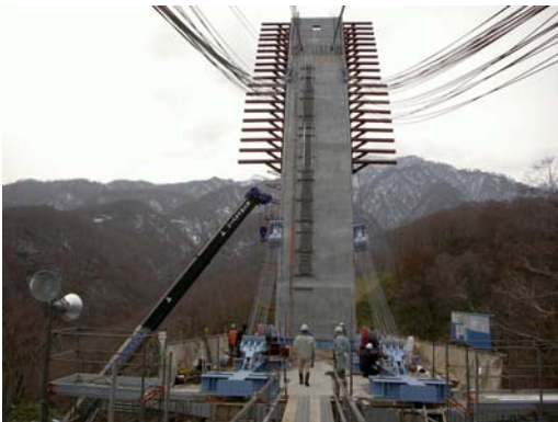
写真-2 ウインチ設置状況
