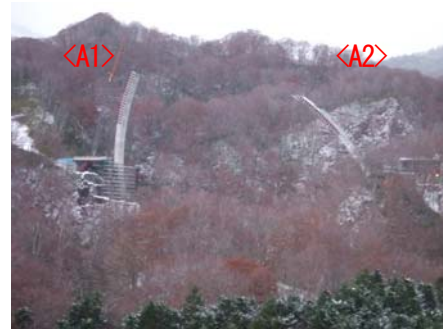
写真-4 A2側3次ロアリング状況
