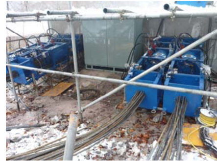
写真-3 ロアリングジャッキ
