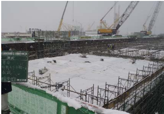
図-7 給熱養生状況
