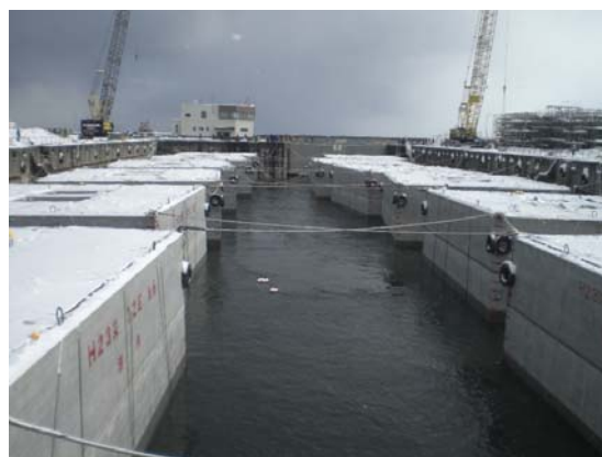
図-12 ケーソン浮上状況
