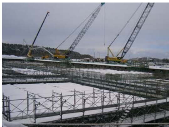
図-9 錯綜するクレーン作業
