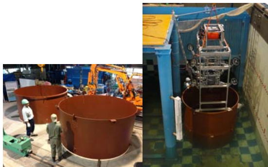
図-8 下部鋼管模型(左)、鋼管模型への装置設置状況(右)
