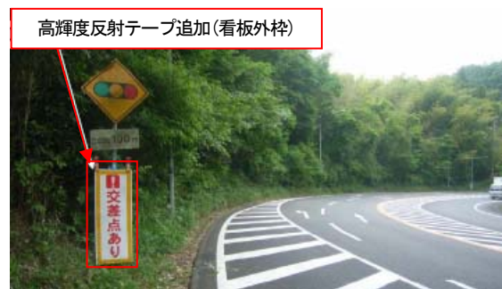
図-14 反射テープ装着後の看板設置事例(下り方向)
