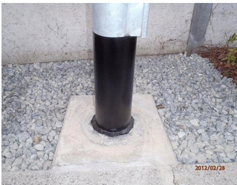
写真-6 補修状況
