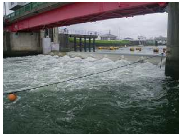
写真-1 調節ゲートオーバーフローによる放流状況
