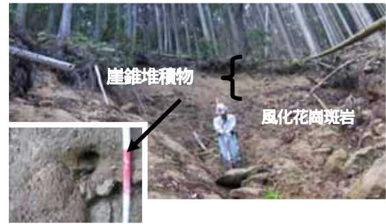
写真-2 表層崩壊とパビングホール（平野川）
