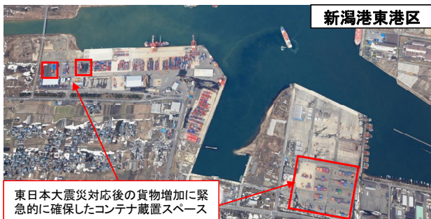
写真-1 緊急的な蔵置スペースの確保（新潟港東港区）
