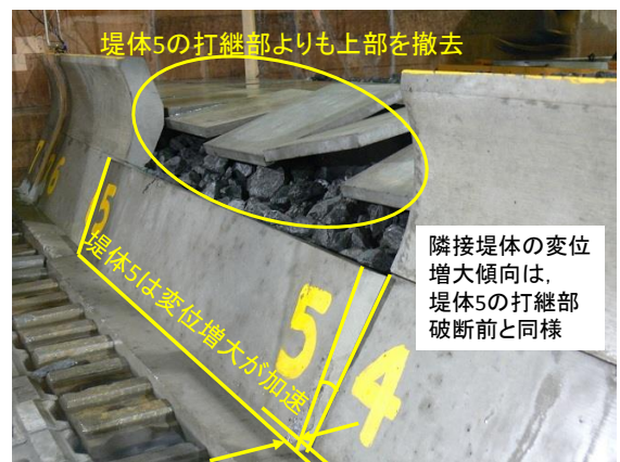
写真-7 堤体No.4及びNo.6の変位
