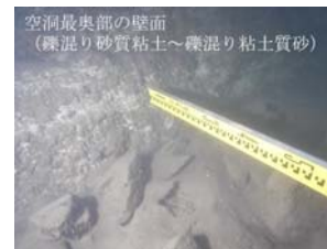
写真-5 洗掘最奥部状況
