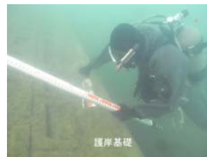
写真-3 潜水調査計測状況
