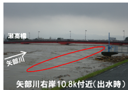
写真-1 H24.7九州北部豪雨時の増水状況
