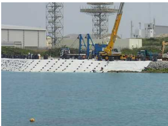
図-6 防砂シート敷設状況について
