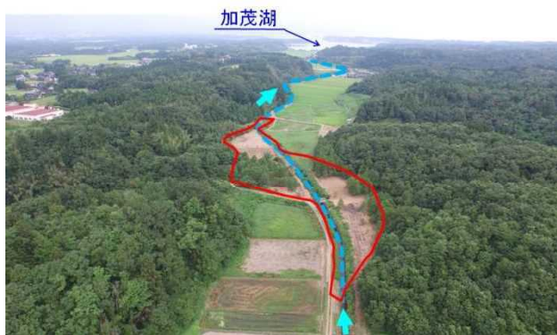
写真-2 天王川中流域 事業箇所
