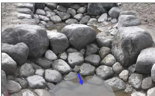
写真5 並べ替え前 (水は石の表面を流れない)
