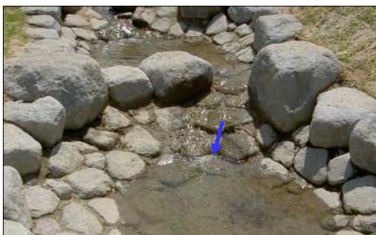
写真6 並べ替え後 (水は石の表面を流下)
