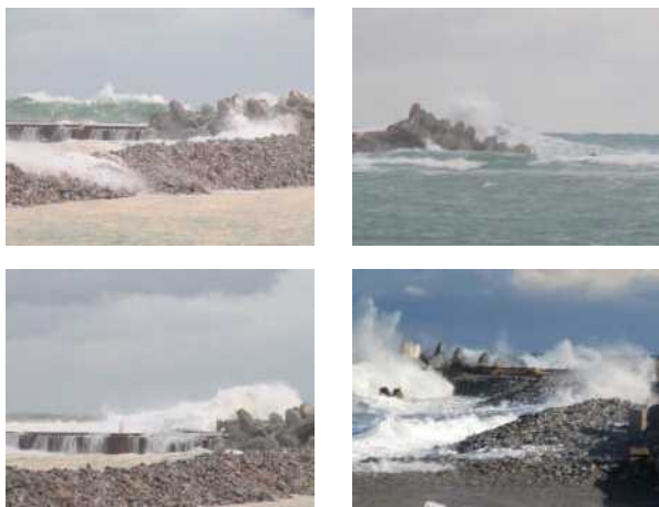
図-3 傾斜堤護岸への高波浪の来襲
