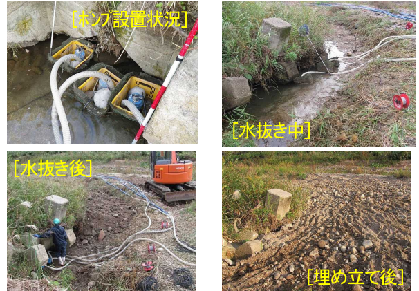
写真-3 「水抜き」及び「埋め立て」実施状況
