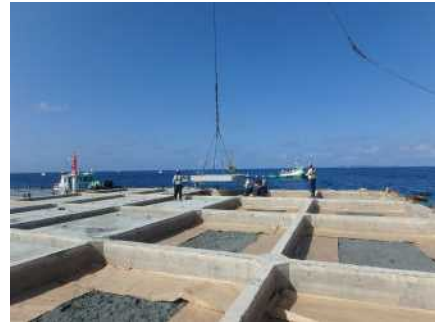
図-7 ケーソン蓋コンクリート設置状況
