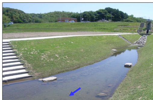
写真10 取付水路 完成から1ヶ月後
