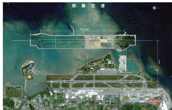
図一 1 3 那覇空港進捗状況(平成28年8月現在)
