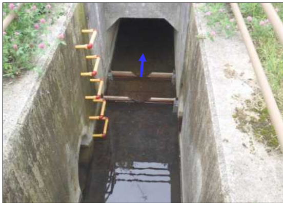
写真12 川裏水路における角落しを用いた段差解消
