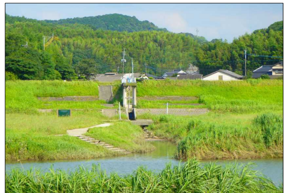
写真16 完成から1年後の御徳第一排水樋管
