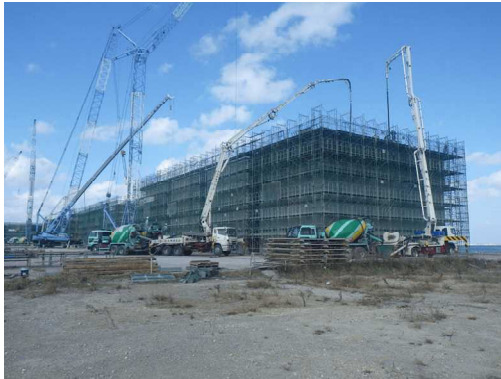
図-5 ケーソンの陸上製作
