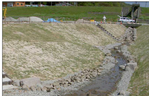
写真9 取付水路 施工状況
