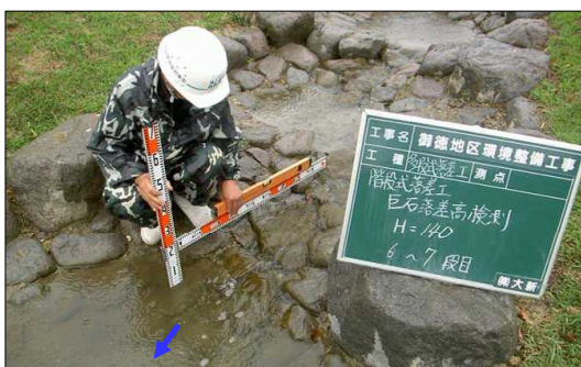
写真7 落差工高低差 20 cm以下
