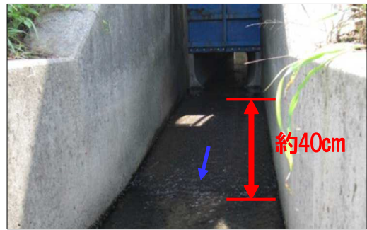
写真3 涵管底盤と川表水路【整備前】
