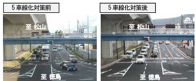
写真-1 左：対策前 右：対策後
