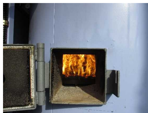
図-9 ペレットボイラーの燃焼状況
