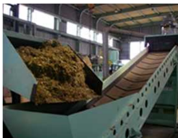
図-3 上：一次破碎機、下：二次破碎機
