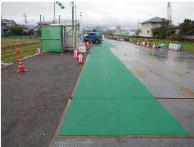
写真一八 作業用通路（是正後）
