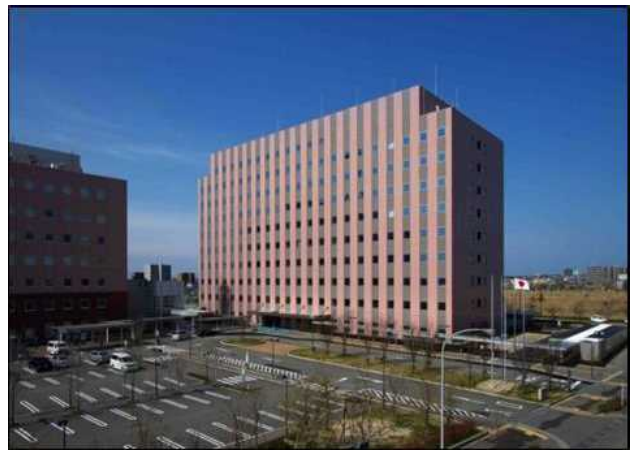
図-3 新潟美咲合同庁舎2号館
