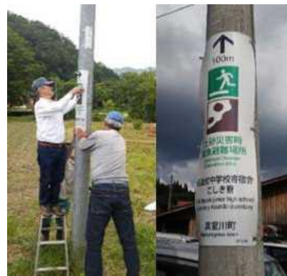
写真10 標識設置の様子
