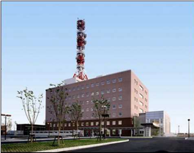
図-1 新潟美咲合同庁舎1号館
