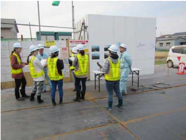
写真一七 作業用通路（是正前）
