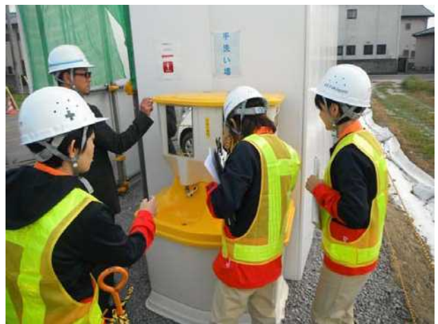
写真-6 仮設トイレ・手洗場の点検
