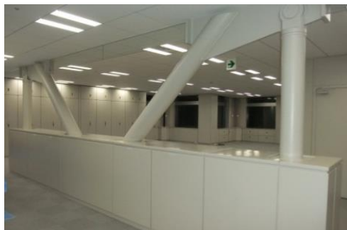
図-4 制振装置の設置状況
