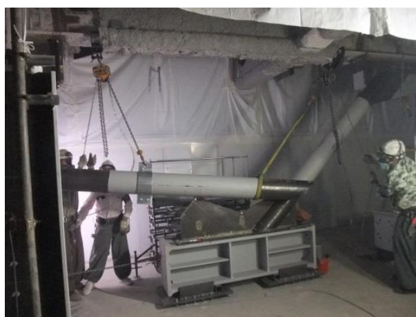
図-8 鉄骨部材の組み上げ過程
