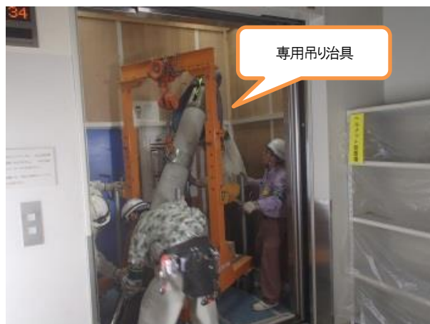
図-7 鉄骨ブレースのエレベータへの搬入作業
