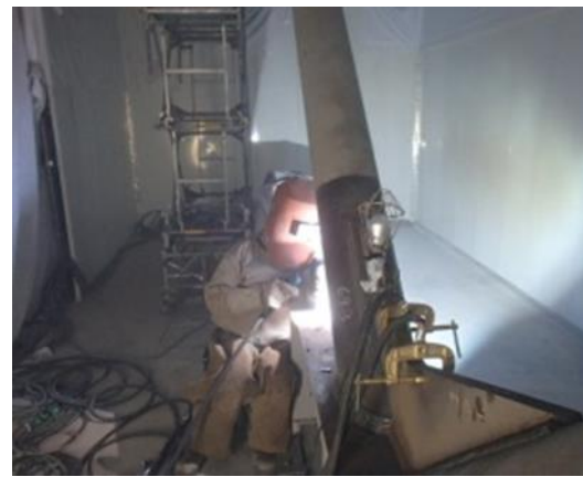
図-9 区画内での現場溶接作業
