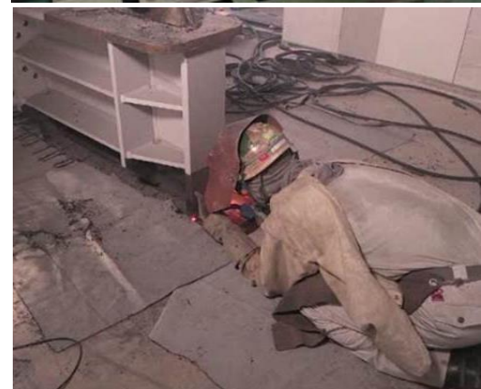
図-11 溶接施工性試験(上)と実際の溶接状況(下)
