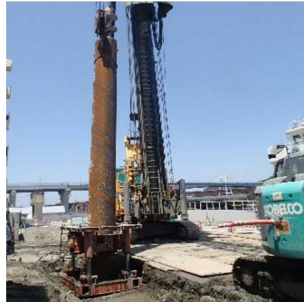
図-12 杭打設状況
