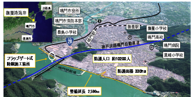
図-1 撫養港海岸桑島瀬戸地区
