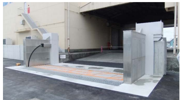
図-2 フラップゲート式陸閘施工箇所
