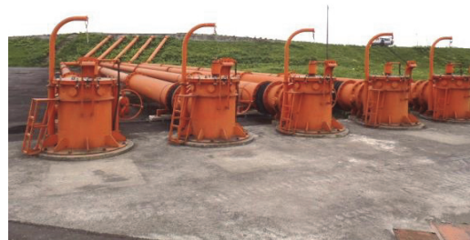
写真-1 救急排水機場外観
