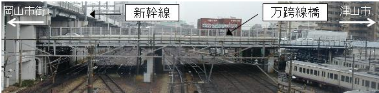
図-4 万跨線橋P2-A2間写真
