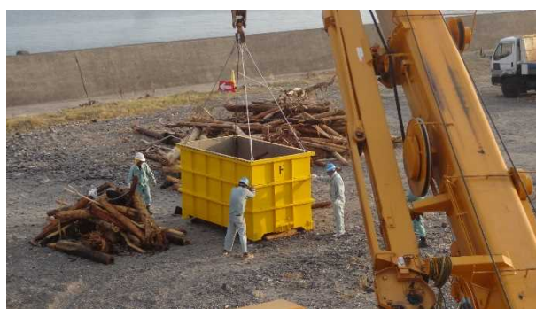
写真-8 回収コンテナの陸揚げ状況(不陸地)
