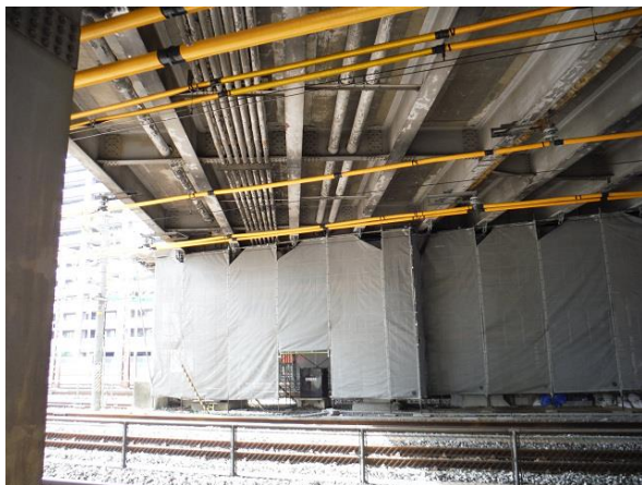
図-5 P2～P3間桁下状況写真
