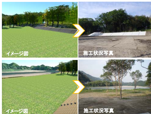
図-13 イメージ図と現地の施工状況
