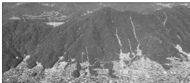
写真-1 緊急事業を進めている緑井・八木地区
