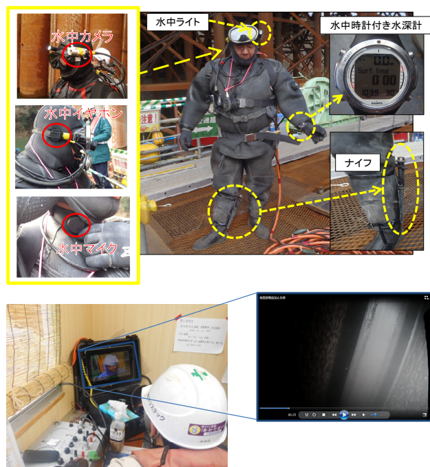
図-13 潜水作業時の装備と水中カメラの映像共有状況
