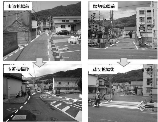
写真-5 市道・踏切拡幅状況
