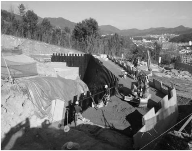
写真-7 INSEM 工法施工状況
