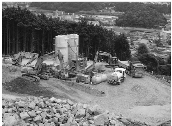
写真-6 ソイルセメント製造状況
