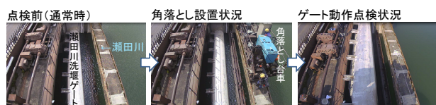
図-8 瀬田川洗堰年点検状況
