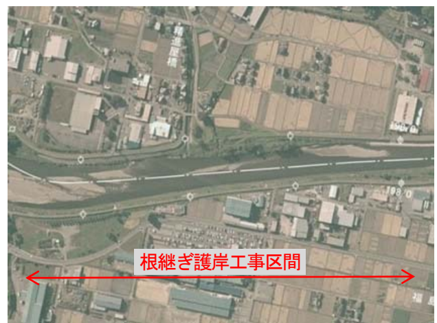
写真-1 平成18年の出水後
