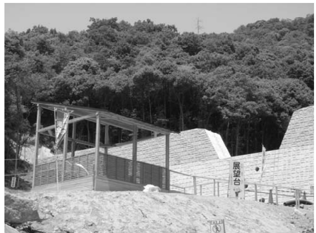
写真-10 設置した工事現場見学スペース
