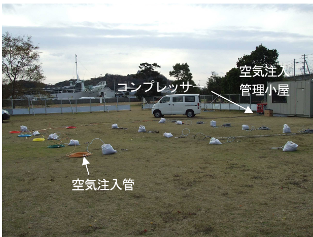
図-1 空気注入不飽和化工法施工写真
