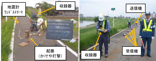
写真-1 物理探査の実施状況 (左) ランドストリーマ方式表面波探査 (右) 牽引式電気探査表
