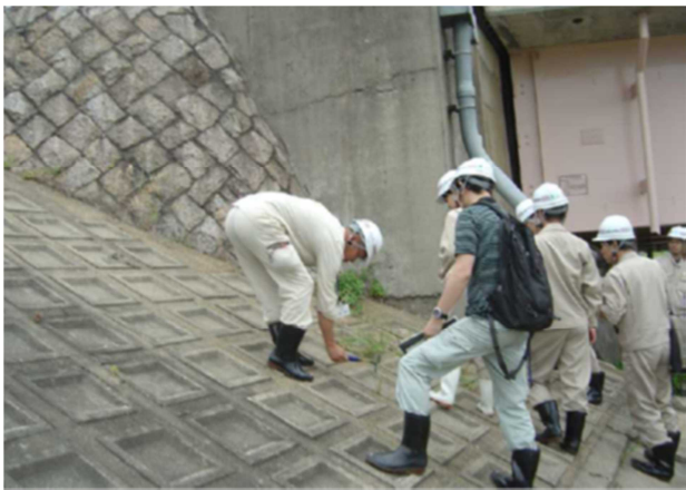
写真－3 点検実習の状況
