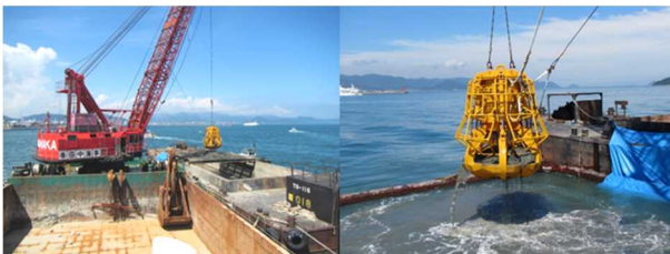
写真-2 海上での浚渫状況
