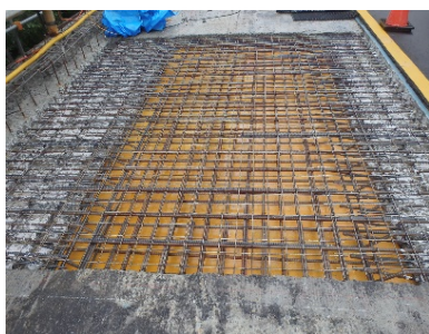
写真-7 フランジ上を残した床版打換
