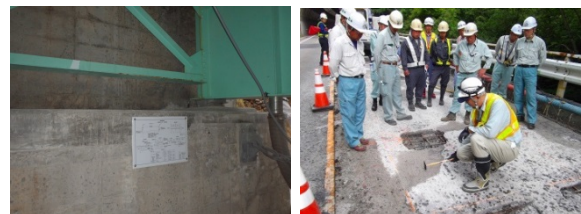
写真-16 橋梁下に設置した補修履歴版・現地講習会の様子
