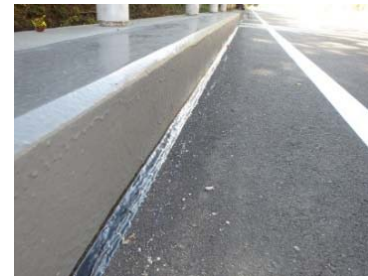
写真-11 高性能防水設置状況
