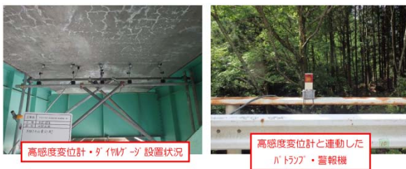
写真-14 計測装置・緊急警報機設置状況
