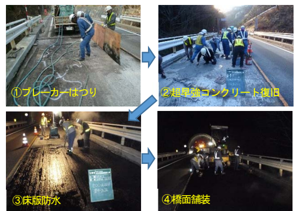
写真-5 前回即日復旧の補修状況
