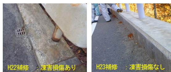
写真-9 繊維補強材を混入したコンクリートの状況
