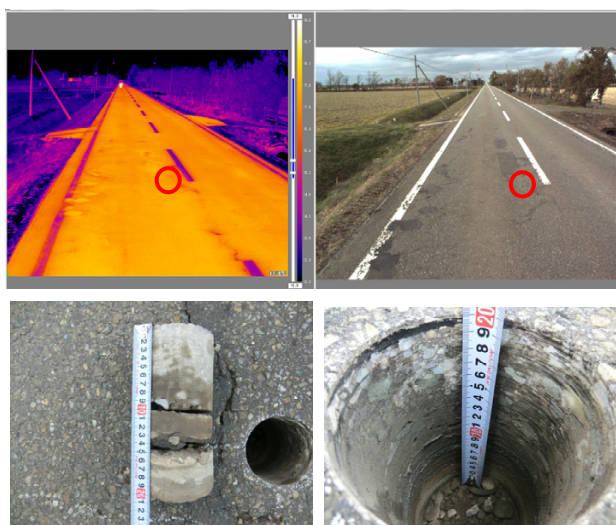
写真-2 赤外線画像異常箇所におけるコア採取状況
