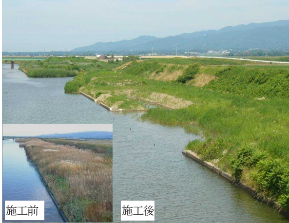
写真-1 国府川高水敷の湿地化
