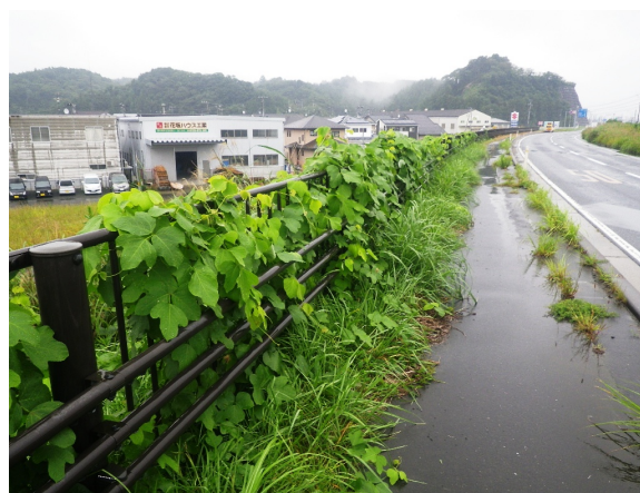
図-9 2017年9月7日 国道45号鳴瀬大橋(東松島市)
