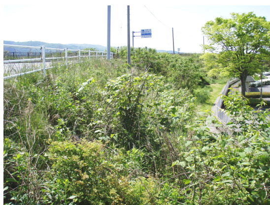
図-1 長大な法面部（R45石巻市河北町地内）
