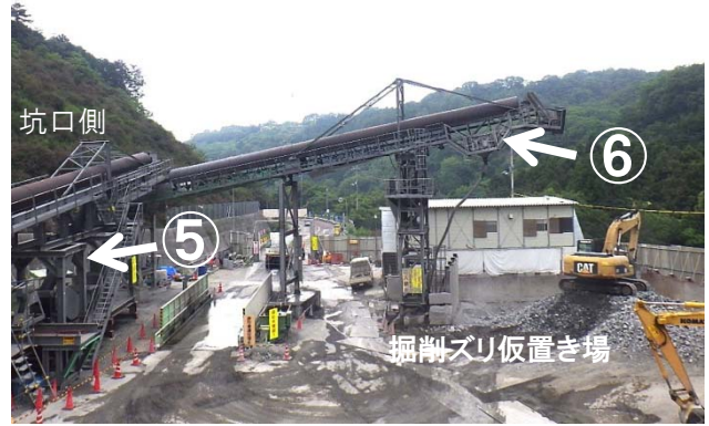
図-5 坑外設備配置
