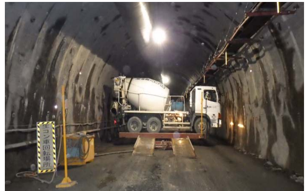
図-7 ターンテーブル使用状況
