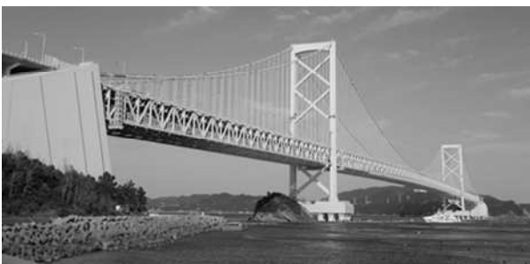
写真-1 大鳴門橋
