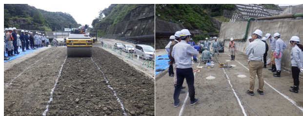
図-16 試験施工視察状況
