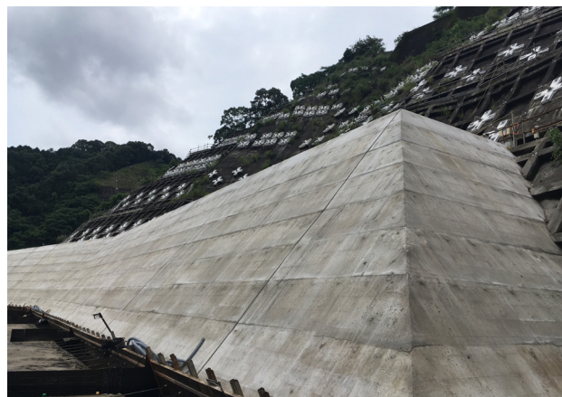
図-17 CSG抑止工完了状況
