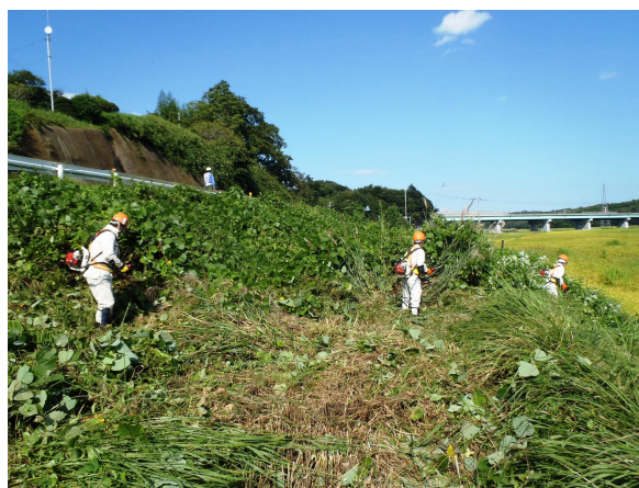
図-7 国側の除草作業
