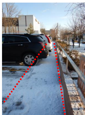
写真-4 T庁舎車止め
