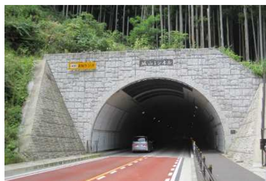
写真-2 城山工区（完成）
