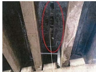
【補修後(橋面防水、弾性シール材)の状況】
