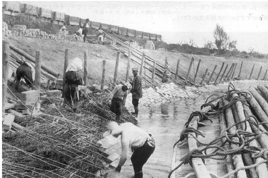
写真-3 岡崎式単床ブロックの施工状況
