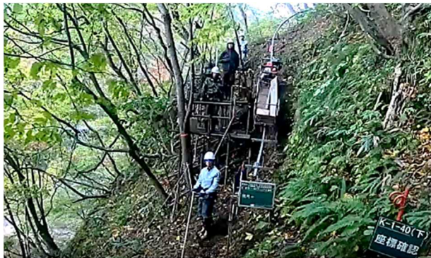
写真-1 急崖地ボーリングの状況
