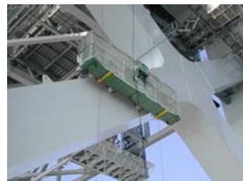
写真-3 大鳴門橋の主塔塗替塗装(斜材用)
