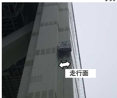
写真-7 外隅面用の運用
