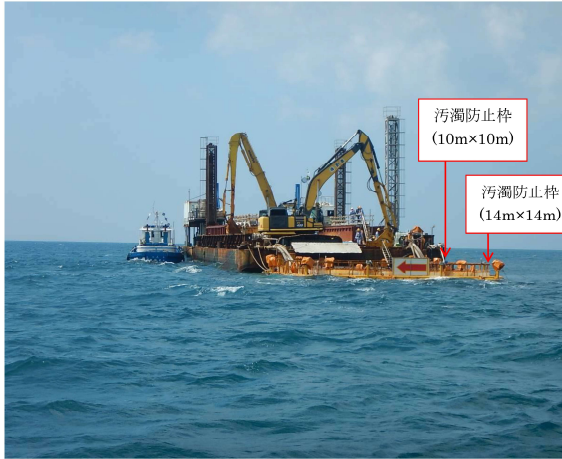
(写真 汚濁防止柵 展張状況)
