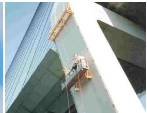
写真-2 磁石車輪式塔作業車(生口橋)
