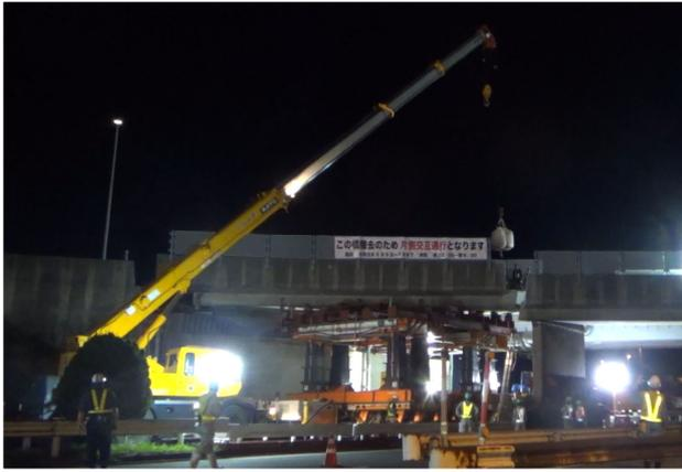
写真-8 クレーンによる大型土のう設置
