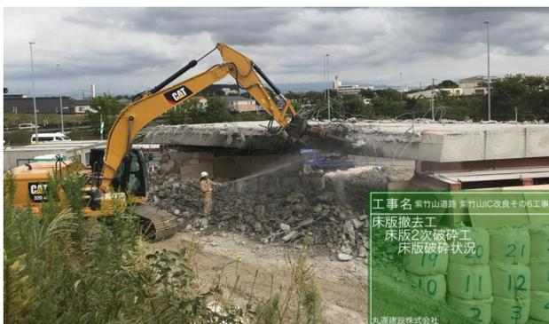
写真-11 解体ヤードでの上部工の破碎作業
