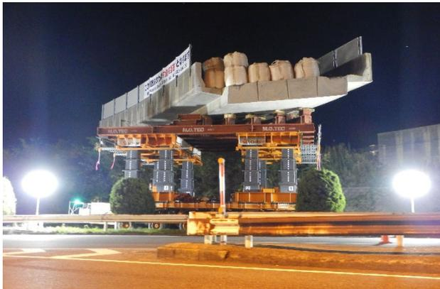
写真-9 上り線側上部工の運搬
