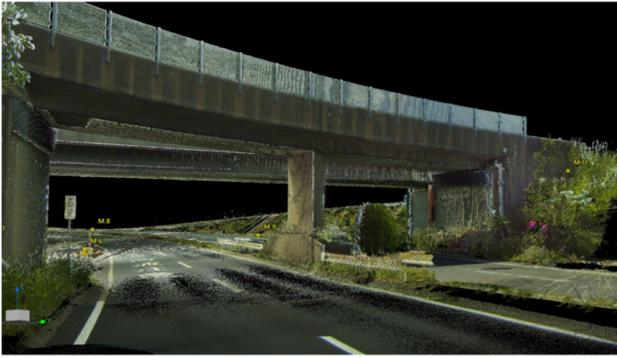
図6 事前測量による3次元点群データ
