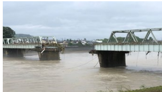
図-1 西瀬橋一部流失の状況
