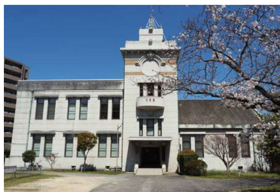
図-1 第1庁舎南面外観
