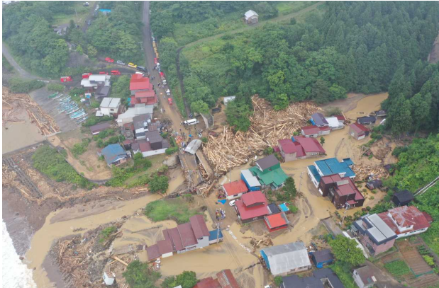
写真-7 小赤川橋落橋現場 (8.12撮影)
