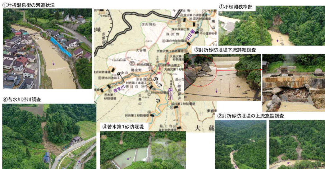
図-1 被災状況把握箇所
