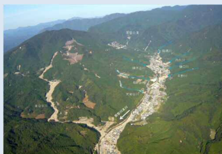
土石流(那智川地区)
