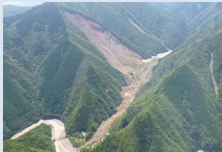
深層崩壊(川原樋川地区)
